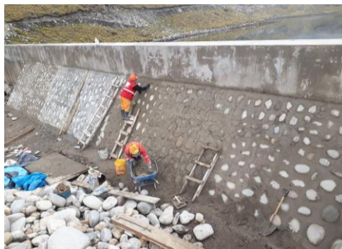
VISTA DE LA CONSTRUCCION DE LA REPRESA 02 DE LA LAGUNA ALLPACCOCHA
