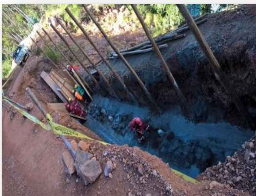
CARRETERA MOYACCASA PULCAY Y RIO PAMPAS
