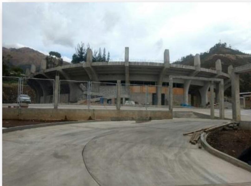
INSTALACIÓN DEL COLISEO CERRADO DE CHINCHEROS
