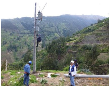
ELECTRIFICACION RURAL DE LAS COMUNIDADES DE AYMARAES
