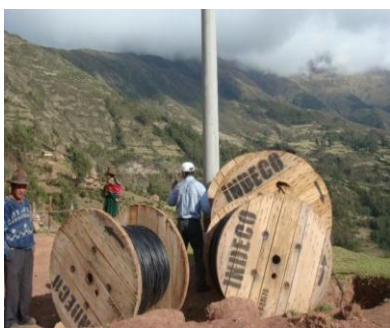
INSTALACION Y ELECTRIFICACION RURAL -ABANCAY
